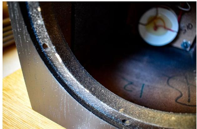
Die Ausfräsungen sind perfekt, die Treiber mit Gewindeschrauben in der Schallwand verankert
